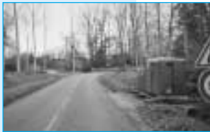
Pont de Cornillas
