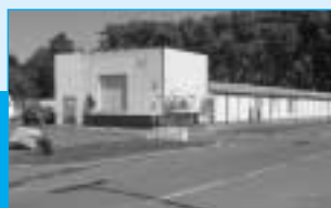
Piscine Route des Charretiers
